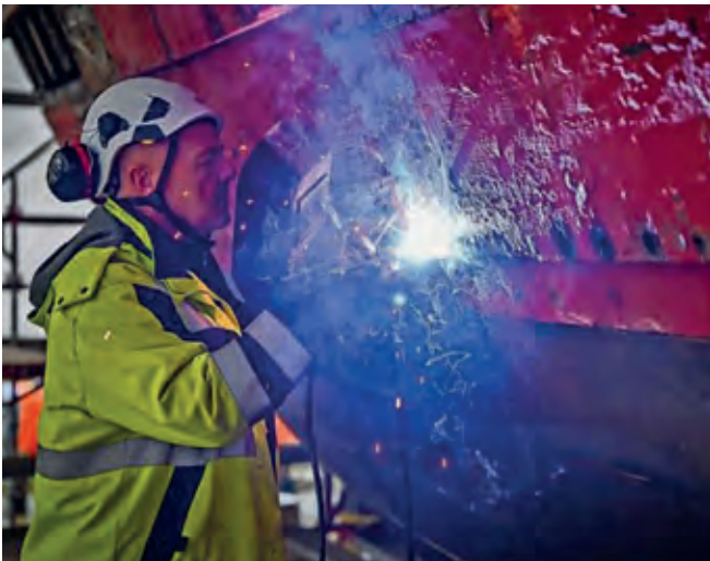
Der Stand der Reparaturarbeiten an der Kogge „Ubena von Bremen“ bei Stahlbau Nord GmbH. Uwe Lah kümmert sich um die Nieten am Schiffsrumpf. Foto: Scheschonka
