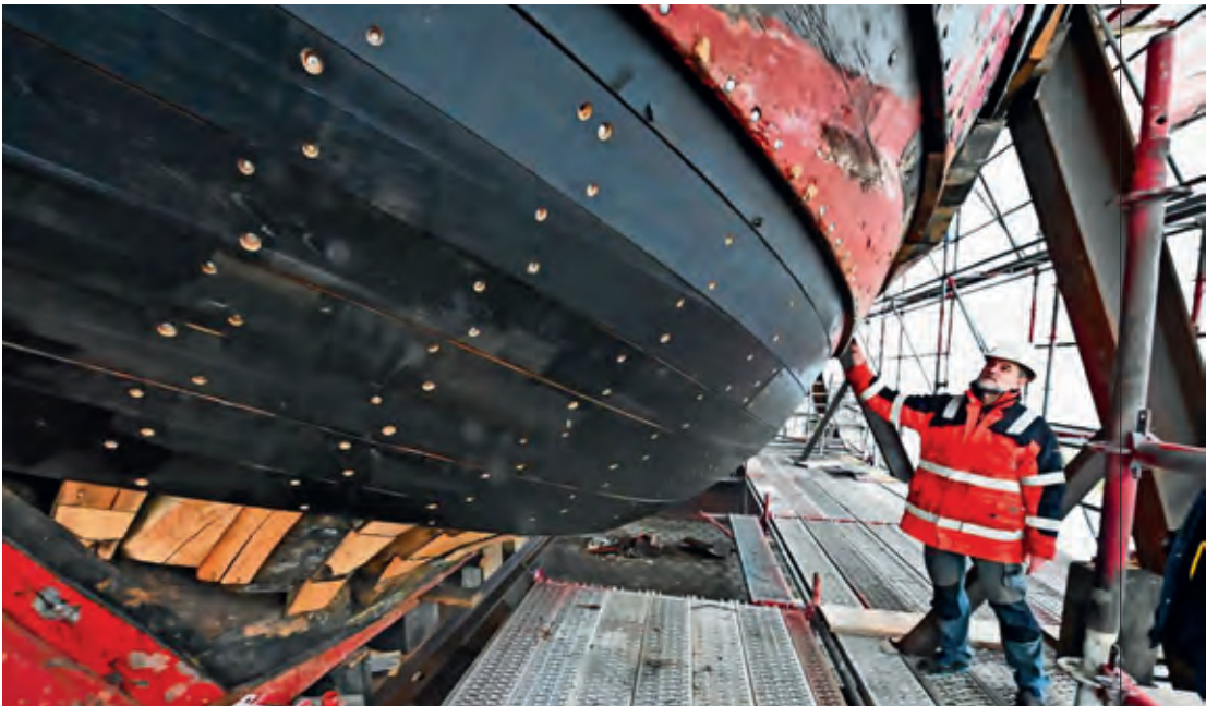
Der Stand der Reparaturarbeiten an der Kogge „Ubena von Bremen“ bei Stahlbau Nord GmbH. Martin Claus zeigt den Fortschritt. Foto: Scheschonka
